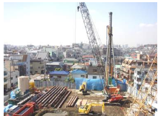
掘削現場写真(平成20年3月25日現在)
