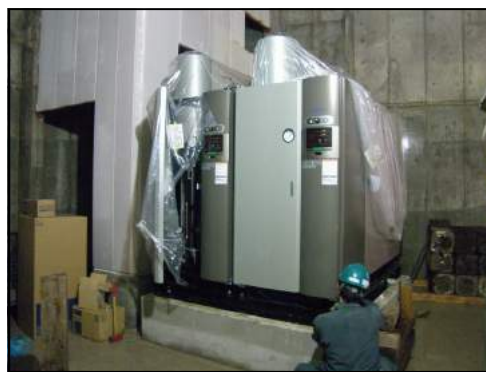
//地下2階 ボイラー設置の様子//
