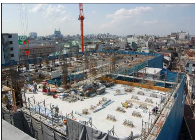
//工事現場・全景 北側屋上より H21.9 現在//
